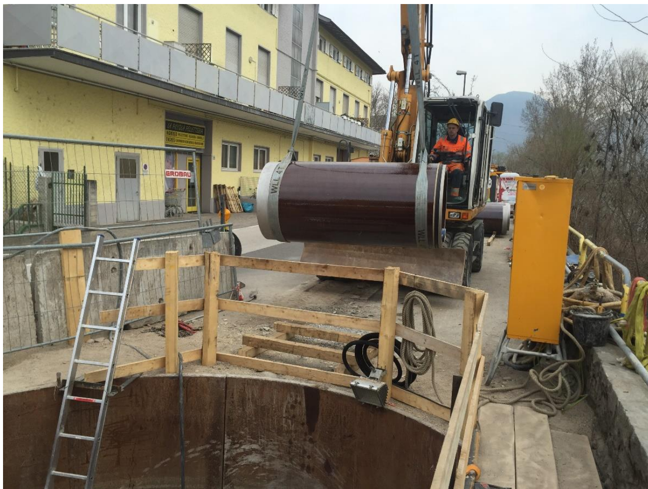
Figura 2-E : Cantiere microtunnelling pozzo di spinta
