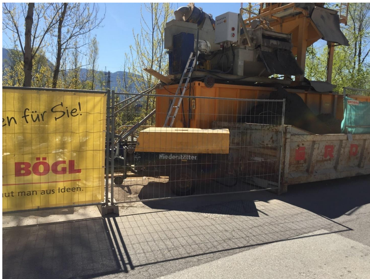
Figura 2-F : Cantiere microtunnelling pozzo di spinta
