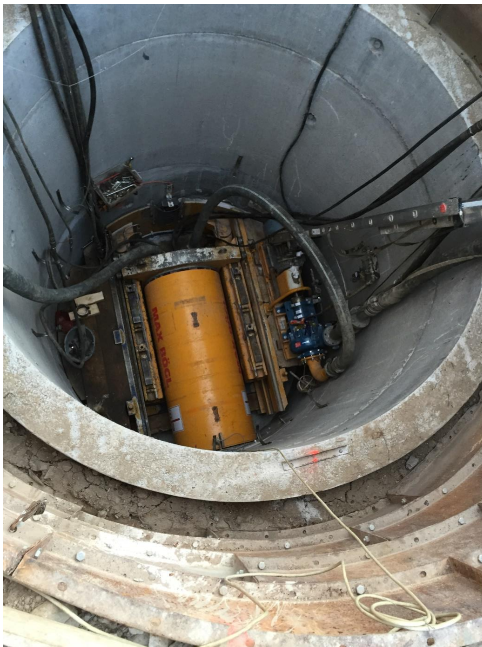
Figura 2-G : Cantiere microtunnelling pozzo di spinta
